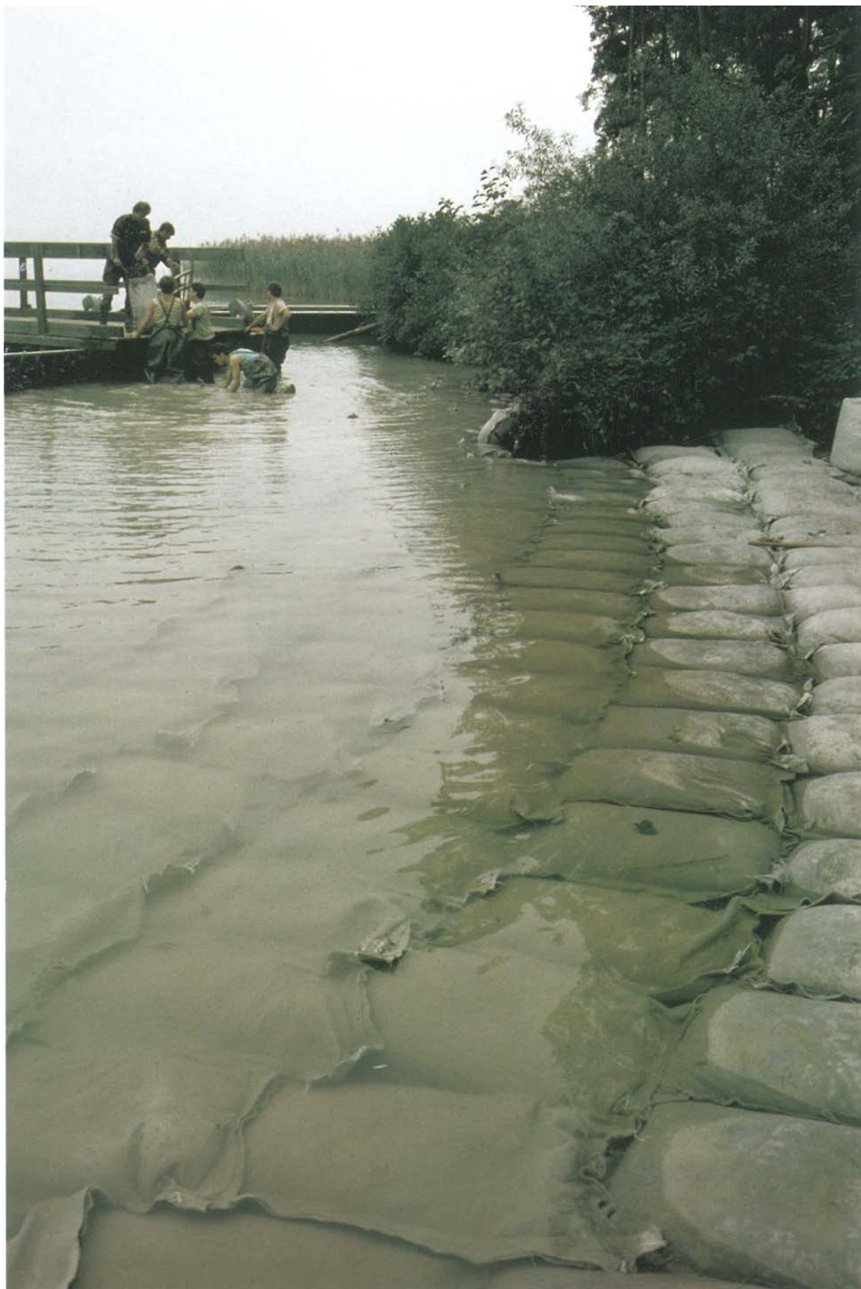
Pl.13.2: Le même site après la pose des sacs de graviers destinés à le protéger de l'érosion. (Photo Service archéologique cantonal, Fribourg)
