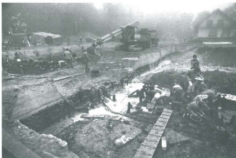
Fig.13.6: Fouille de sauvetage du site néolithique de Montilier (Muntelier/Platzbüenden) en 1979, Fribourg. Photo Service archéologique cantonal.
