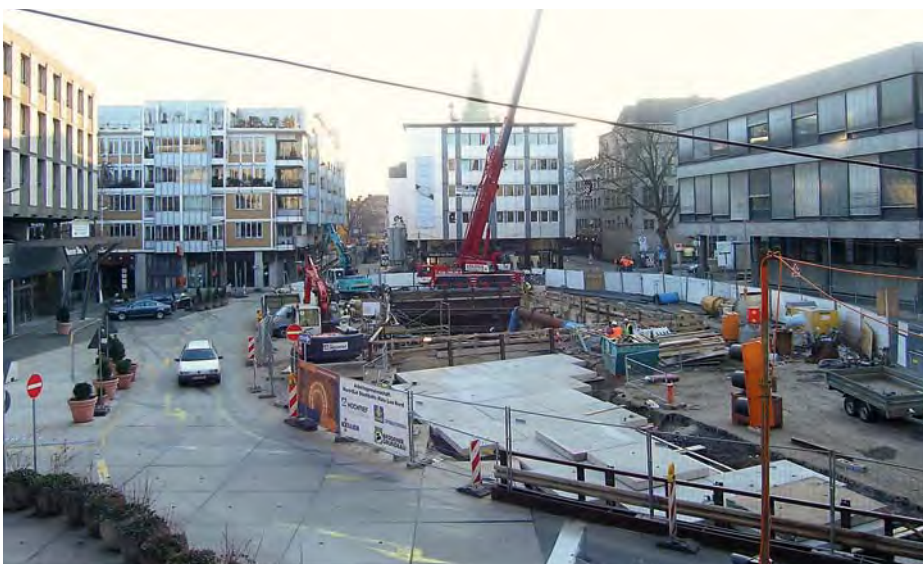
Abb. 15.5: Köln, Kurt-Hackenberg-Platz. Große Teile der Ausgrabungen sind mit Hilfsbrücken überbaut. Die Baustellenlogistik wird über eine Andienöffnung in der Platzmitte gewährleistet.
