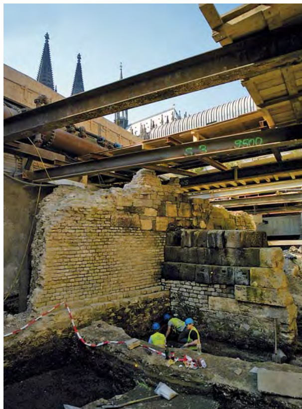
Abb. 15.8: Köln, Kurt-Hackenberg-Platz. Bei den Ausgrabungen wird ein Teilstück der rheinseitigen römischen Stadtmauer mit vermauerter Toröffnung und Kanalauslass freigelegt, Ansicht von Südosten.
