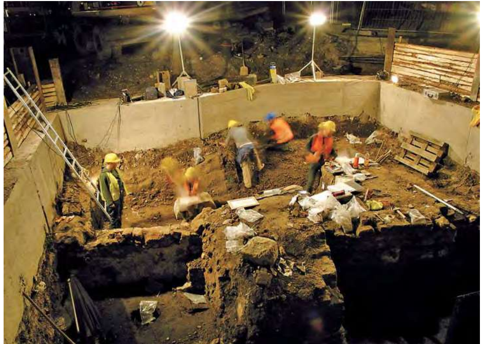
Abb. 15.6: Köln, Severinstraße. Im nächtlichen Scheinwerferlicht arbeiten Archäologen mit Hochdruck an den steinernen Fundamenten der hochmittelalterlichen Deutschordenskirche St. Katharina.
