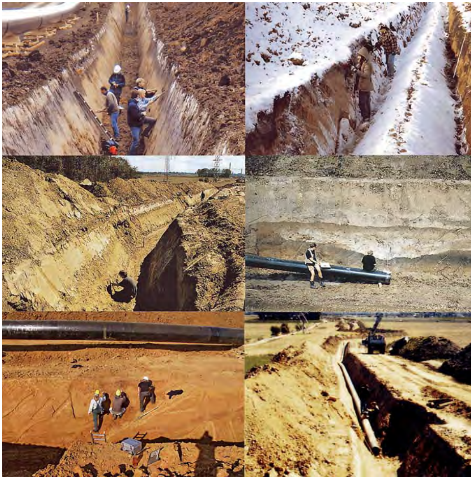
Abb. 1.1: Eine Betreuung der tief greifenden Baumaßnahmen ist aus geoarchäologischer Sicht unerlässlich, doch muss das so weit im Voraus stattfinden, dass genügend Zeit bleibt, die sich daraus ergebenden archäologischen Ausgrabungen zu planen und durchzuführen, und das nicht nur im Leitungsgraben, sondern möglichst flächig im gesamten Baustreifen. Insoweit darf dies wegen des potenziellen Zeitverzugs nicht erst den Bau begleitend geschehen.
