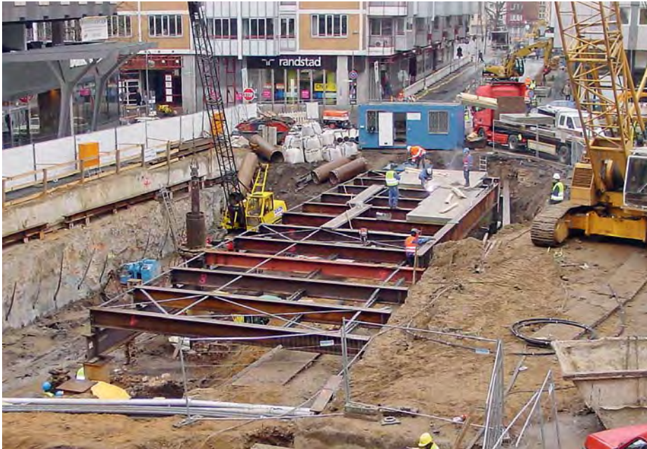
Abb. 15.3: Köln, Kurt-Hackenberg-Platz. Die archäologische Untersuchungsfläche wird mit Hilfsbrücken aus Stahlträgern und Betonplatten abgedeckt.
